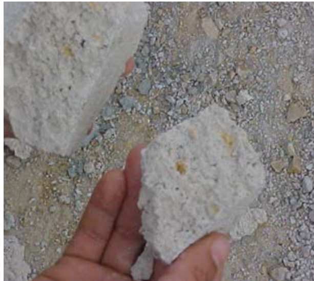
Figura 123. Fragmento de bloque de concreto contaminado con materia orgánica.
