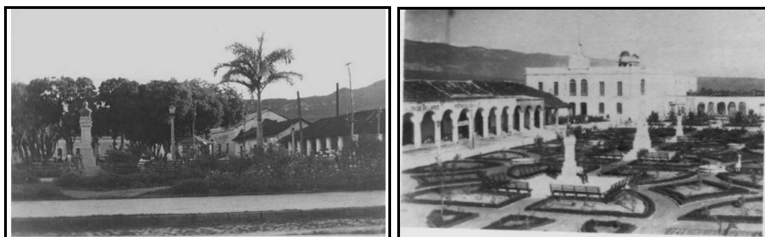
Figura 122. Fotografías casas administrativas (izquierda) y parque central (derecha) en 1926 con techos de teja de barro (Montiel, 1975).
