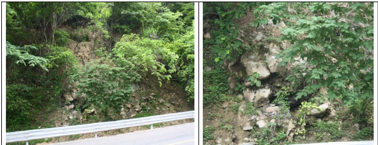
Figura 21. Fotografía izquierda, se aprecia la disposición de bloques de roca caliza. Tramo Tuxtla – San Fernando. Fotografía derecha, se muestran bloques de caliza asociados a fracturamiento debido a fallamiento.
