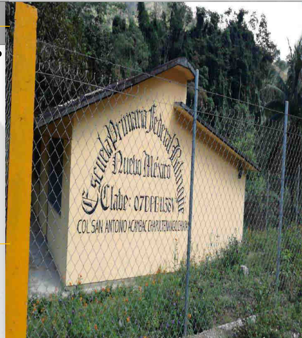
Fotografía: San Antonio Acambac
